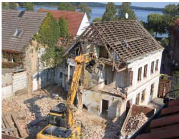
Der Abriss des Eckhauses Schulstraße/Fischerstraße war der Startschuss zur Neubebauung des letzten Filetstücks in der Innenstadt.
