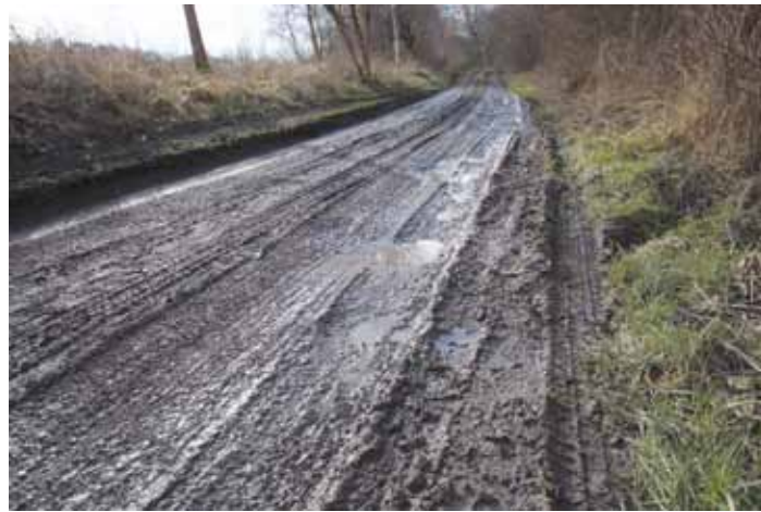
Der Vierowweg ist einer der wichtigsten seenahen Spazierwege.
